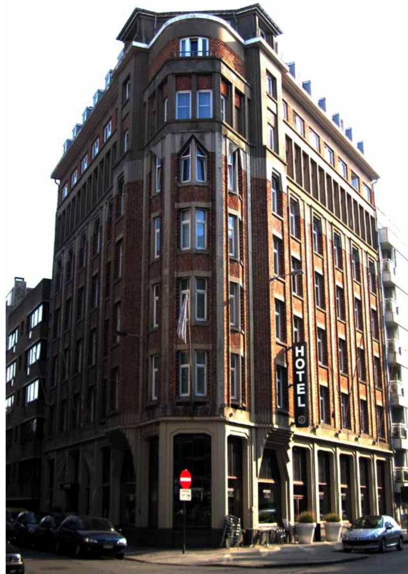
Hotel Mondo, anno nu. Het buitenschrijnwerk is reeds volledig vernieuwd. De gevelrestauratie volgt nog en is de laatste fase van de renovatie.
